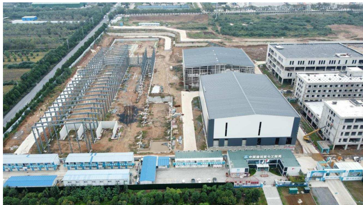
济源市建筑垃圾资源化利用项目施工现场图一
