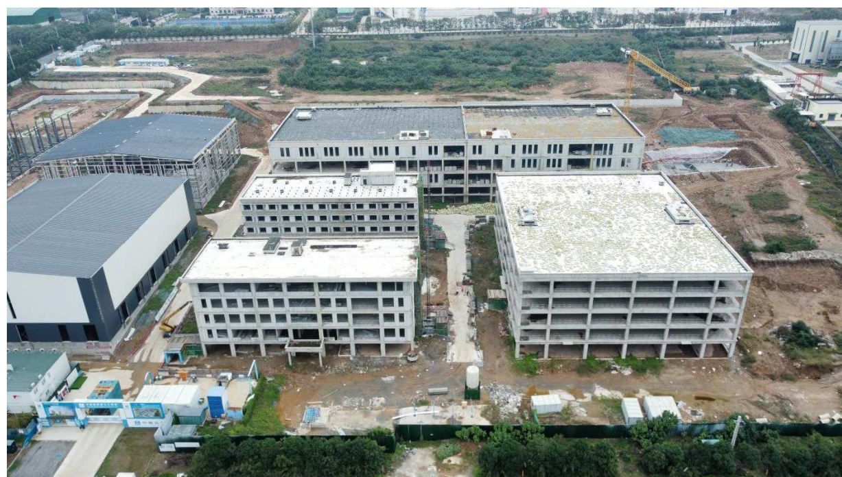
济源市建筑垃圾资源化利用项目施工现场图二
